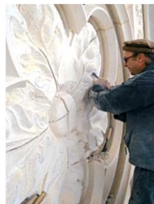
Pentalobes des gâbles: 1. Après pose de la pierre de remplacement. 2. Sculpture en cours (Leandro Berra). 3. Original, côté sud (partiellement refait début XX e s.).
