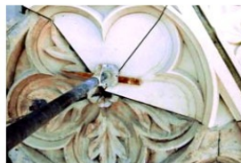
Pentalobes des gâbles: 1. Après pose de la pierre de remplacement. 2. Sculpture en cours (Leandro Berra). 3. Original, côté sud (partiellement refait début XX e s.).
